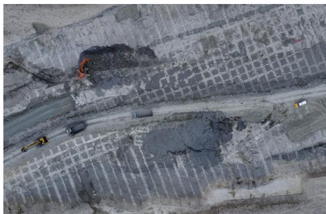
Bilder: Grunnforsterkning på Tiller-Flotten i Melhus. Foto: NGI
