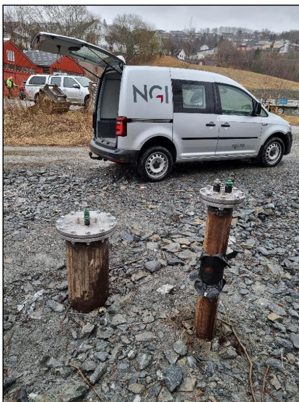
Foto: Montering av energipeler i Malvik kommune, NGI.
